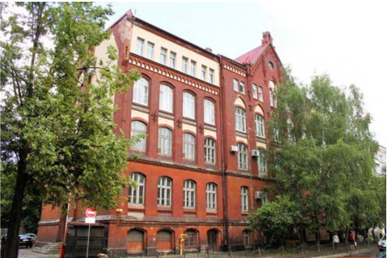
Königsberg, ehemalige Bauwerkschule in der Schönstraße
